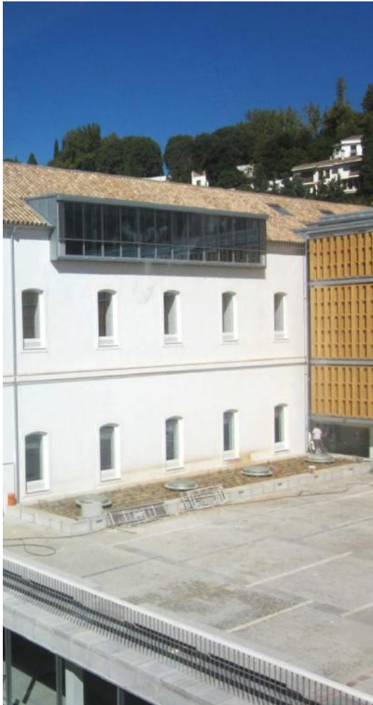
(8) Patio sur I Cubierta Aula Magna
